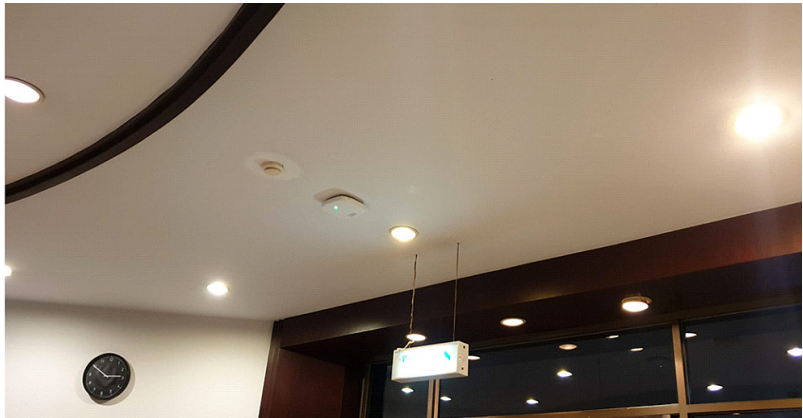
จุดติดตั้งเพิ่มเติม ณ อาคารจามจุรี 4 ชั้น 2
