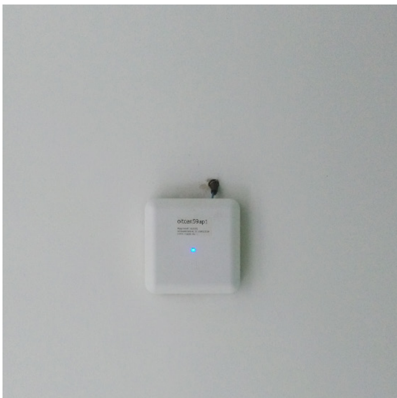
ภาพที่ 2.11 อุปกรณ์ access point อาคารจามจุรี 3
