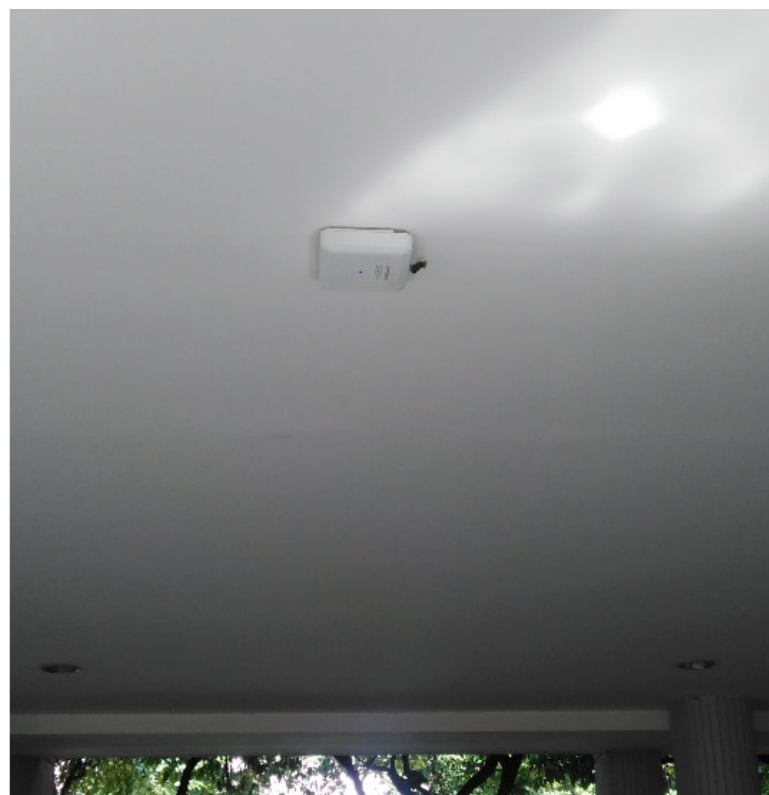
ภาพที่ 2.11 อุปกรณ์ access point อาคารจามจุรี 3
